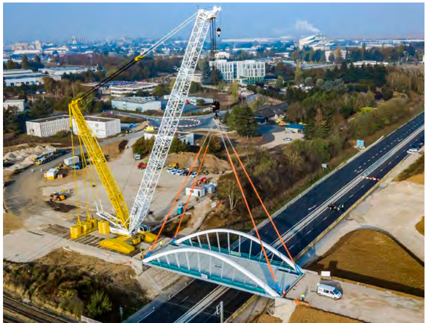
Der französische Kranverleih Mediaco setzt seinen gebrauchten Liebherr-Raupenkrane LR 1600/2 beim Brückenbau in Blois, Frankreich, ein.
