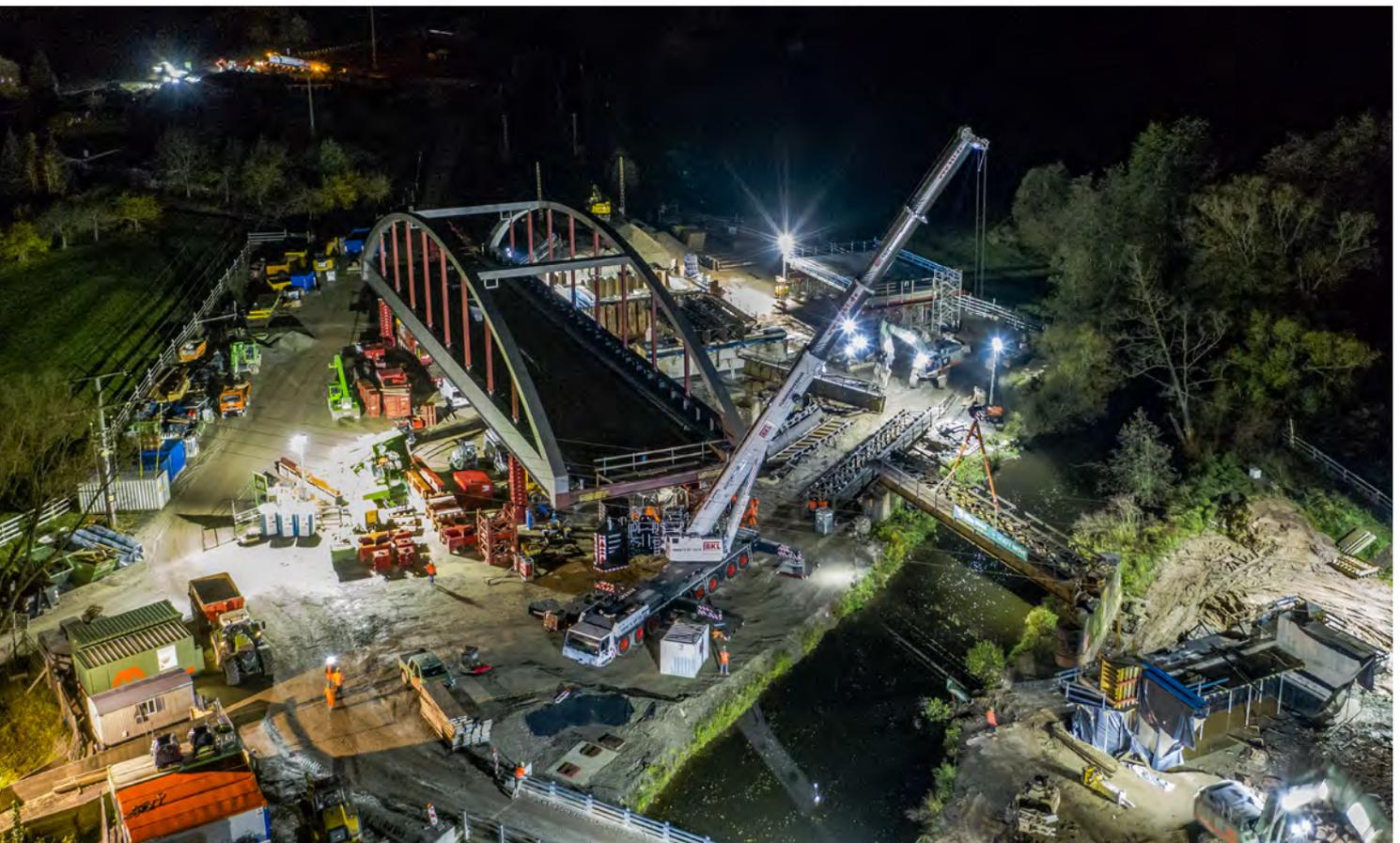
Extrem beengtes Setting: Nur wenig Spielraum hatte der LTM 1650-8.1 beim Nachteinsatz auf seiner ersten Baustelle. Der Drehbühnenballast musste bei Lastaufnahme sogar unter die neue, aufgebockte Brückenkonstruktion schwenken.
