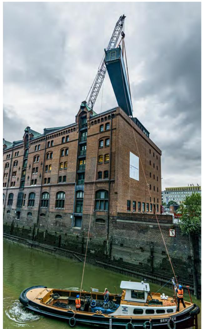
Ein kleiner Schleppkahn übernimmt die langen Halteseile, als die Brücke über den Kanal geschwenkt wird.
