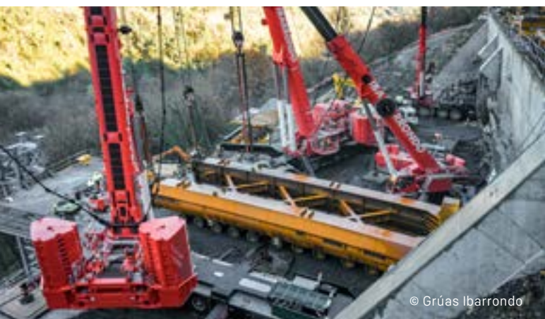
Geballte Liebherr-Power auf engstem Raum bei der gemeinsamen Arbeit.
