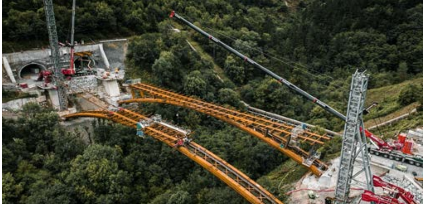
Mit seinem langen Ausleger streckt sich der LTM 1650-8.1 mit schweren Stahlteilen am Haken über das Tal, um sie punktgenau auf das Viadukt zu heben.
